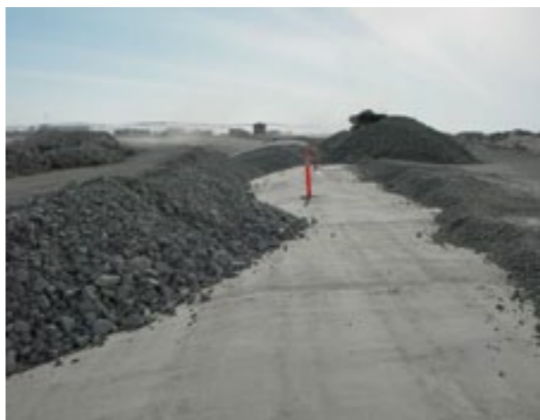
Рис. 4. Покрытие мембраны размером менее 400 мм, использованное на хранилище
