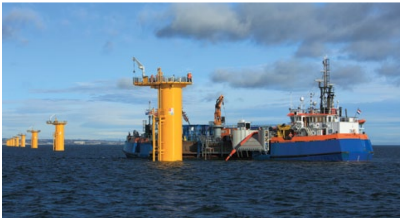
Рис. 4. Судно для бокового отвала камней HAM 601 на строительстве морской ветрофермы
