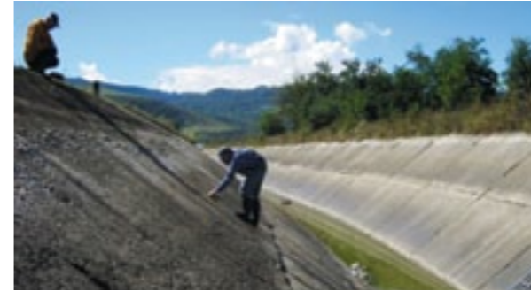
Рис. 2, 3. Деривационный и отводящий каналы. Обследование георадаром
