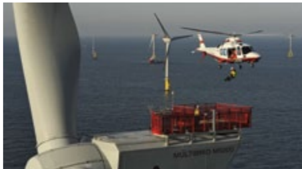
Рис. 3. Обслуживание ветряной турбины шельфового ветрогенератора
