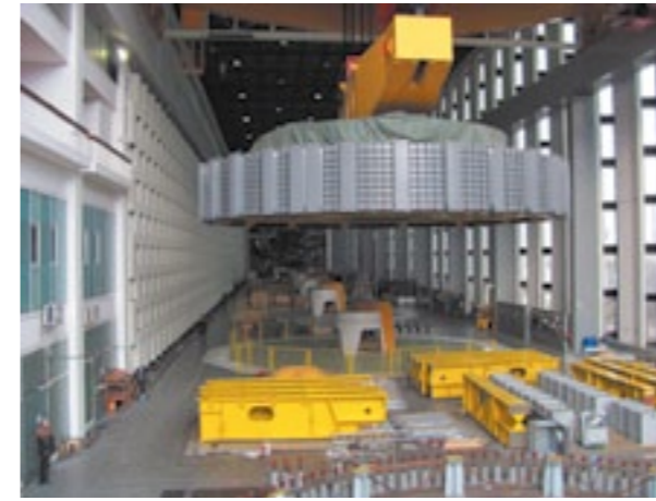
Рис. 2. Реконструкция гидрогенератора ГЭС Джердап-I
