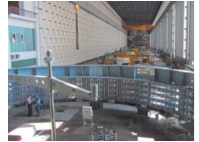
Рис. 2. Реконструкция гидрогенератора ГЭС Джердап-I
