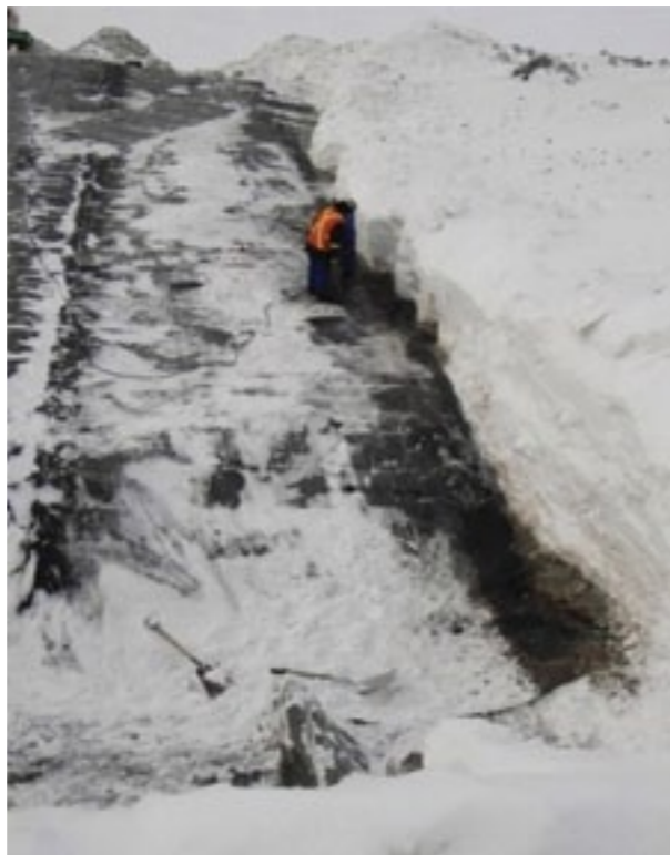
Рис. 3. Очистка снега во время укладки битумной геомембраны в водохранилище № 2
