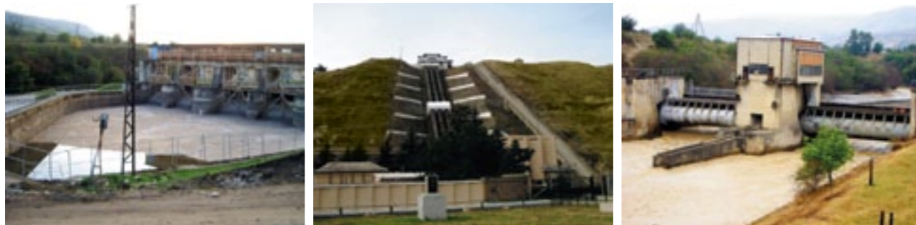
Рис. 1. Сооружения Баксанской ГЭС
