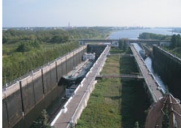
Рис. 2. Рыбинский шлюз (камера осушена)
