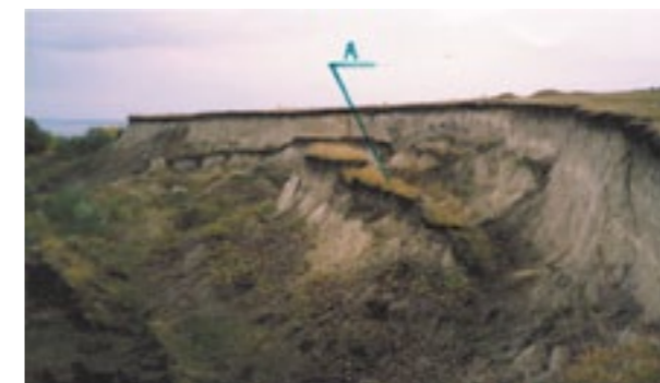
Рис. 1. Общий вид оползневого склона
