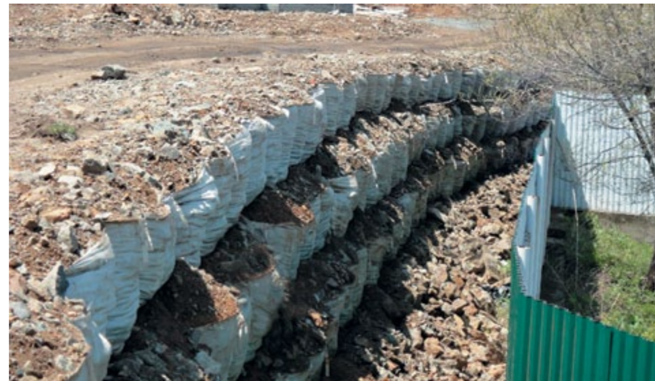
Рис. 5. Общий вид сооружения
