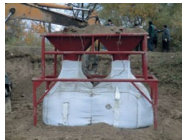
Рис. 1. Заполнение геоконтейнеров при помощи загрузочного бункера
