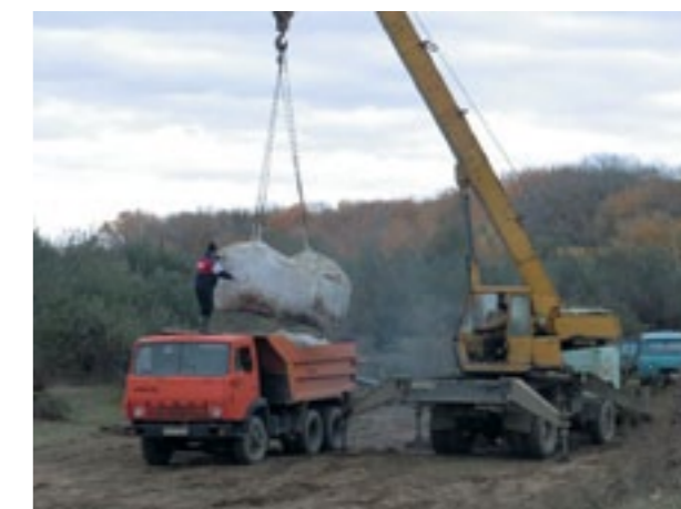
Рис. 2. Погрузка заполненных контейнеров в автосамосвал
