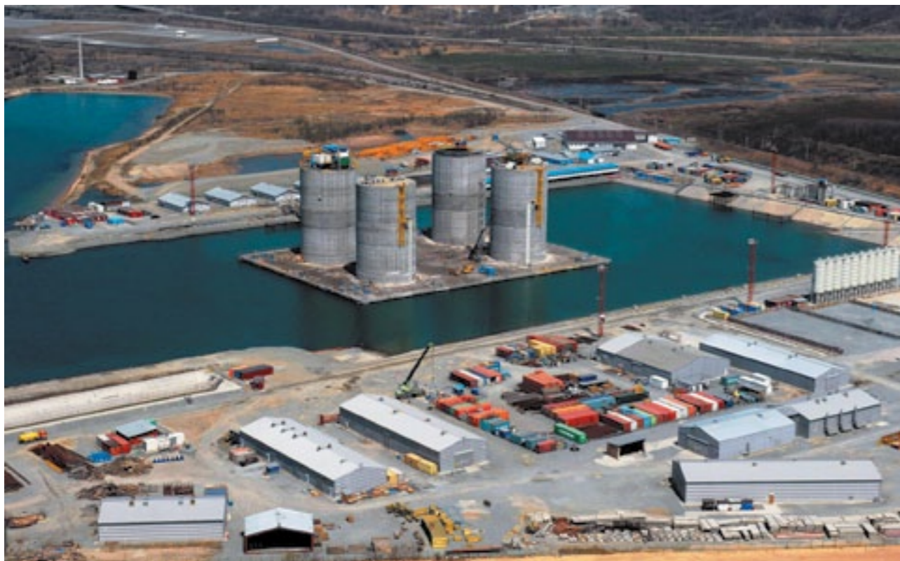
Рис. 3. Общий вид сухого дока в порту Восточный
