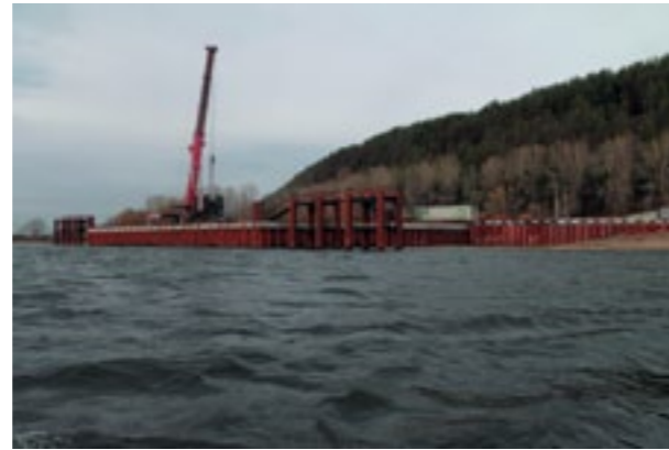
Елабуга. Причал для разгрузки крупнотоннажного оборудования
