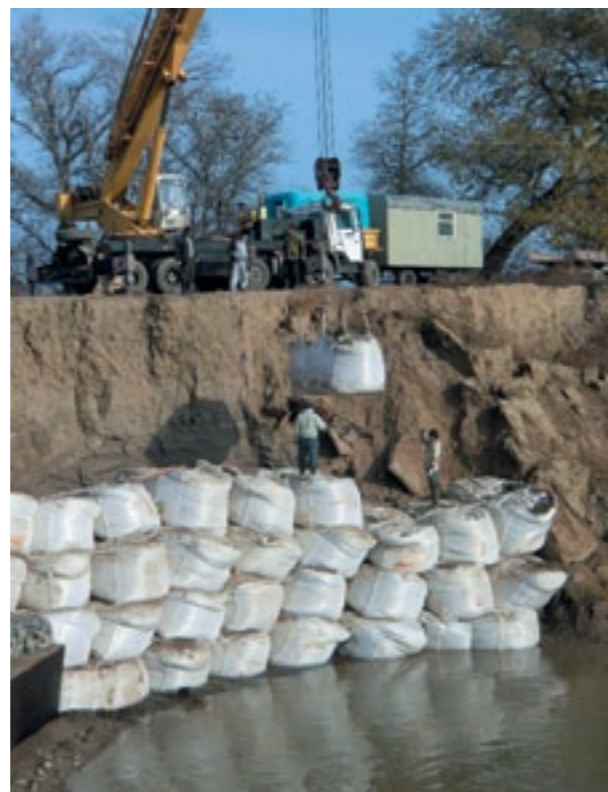
Рис. 3. Монтаж конструкции укрепления берега
