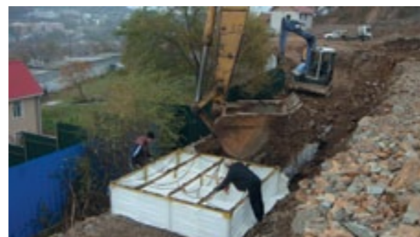
Рис. 4. Заполнение многосекционных геоболочек скальным грунтом
