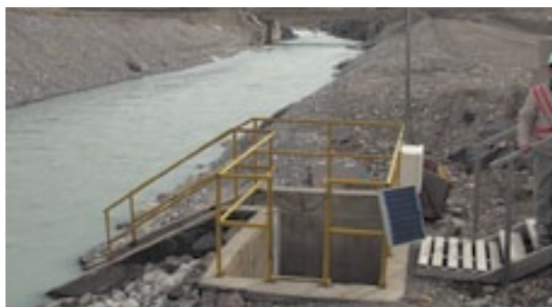
Рис. 7. Июль 2012 г. Пульпопровод через р. Кумтор и гидроствор «Кумтор Оперейтинг Компани» на р. Кумтор — в 4 км от истока
