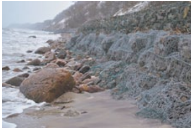
Рис. 5. Состояние габионов у г. Светлогорска после четырех лет эксплуатации, 2013 г.
