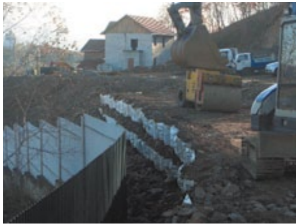
Рис. 6. Устройство выравнивающего слоя на поверхности подпорной стенки
