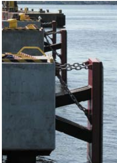
Фото 2. Отбойные устройства с металлическим каркасом
