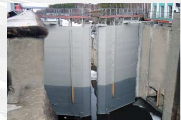
Шлюз Беломорканала (Россия). Антикоррозионная защита ворот. Системы покрытий: надводная часть — Sika Permacor 2004 (грунтовка) + Sika Permacor 2330 (покрывной материал), надводная часть Sika Epiter TF130.
