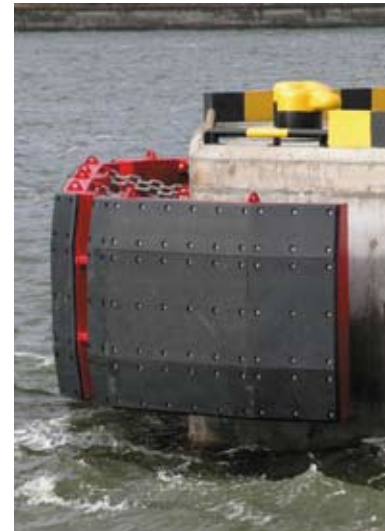
Фото 4. Вариант защиты угла причала
