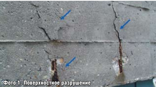
Фото 1. Поверхностное разрушение
