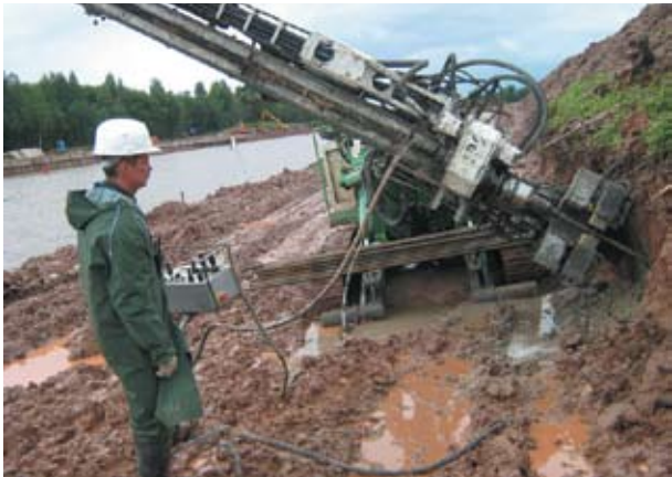
Рис. 2. Устройство опытного анкера в глине
