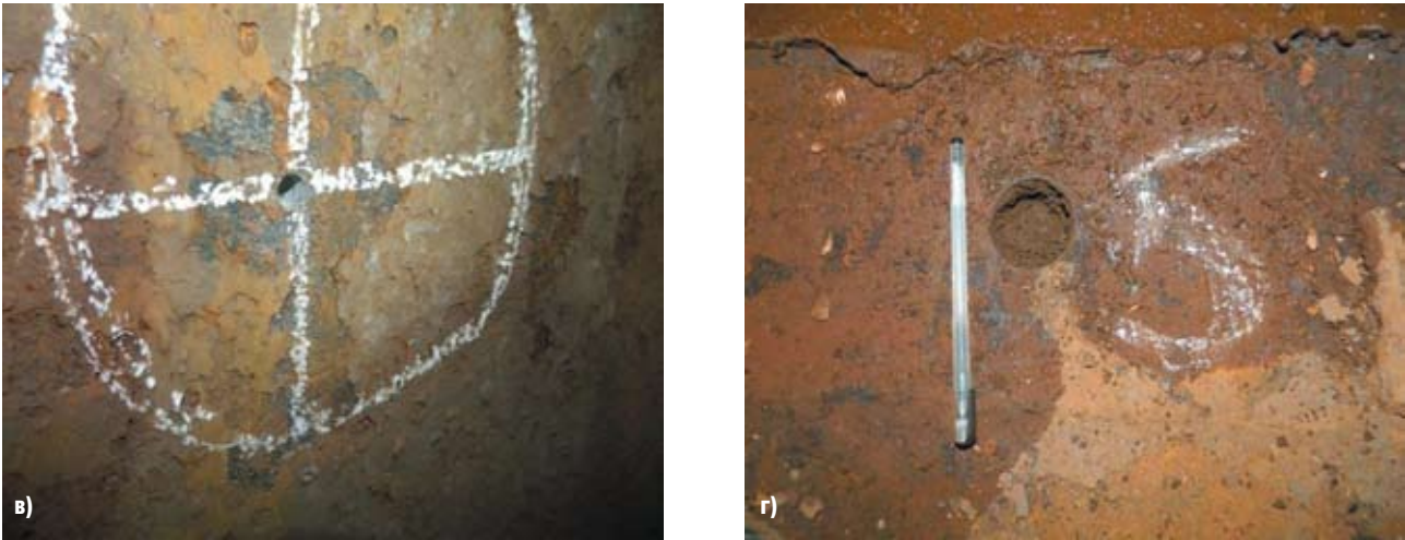
Рис. 7. Типичные коррозионные поражения оболочки водоводов СШГЭС: а) язвенная коррозия в зоне срезанной монтажной детали; б) коррозия в зоне сварных швов; в, г) пластовая коррозия облицовки входной части водоводов
