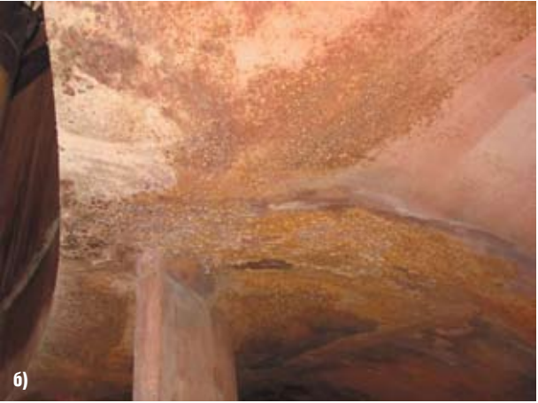
Рис. 11. Дефекты защитного покрытия спиральных камер гидроагрегатов Богучанской ГЭС
