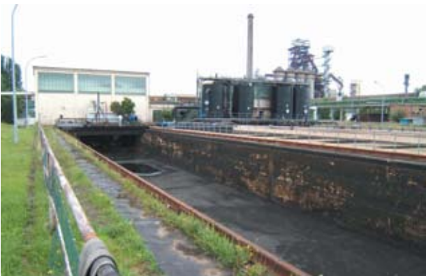
Рис. 2. Ванна осаждения с загрязненным нефтепродуктами основанием
