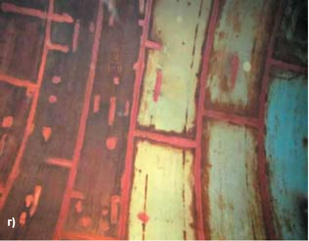
Рис. 10. Вид защитного покрытия оболочек турбинных водоводов Богучанской ГЭС. Видны участки покрытия разного цвета, выполненные в разное время. Через защитное покрытие повсеместно проступает коррозия
