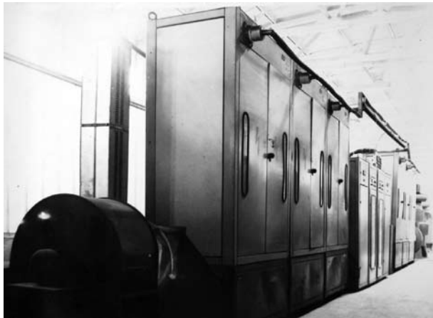
Фото 1. ПТУ15000 с преобразователями 3,3 кВ ВИПЗ2 (съемка сделана во ВНИИ «Электромаш»)
