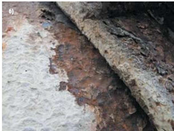
Рис. 1. Коррозия напорного трубопровода Баксанской ГЭС:
