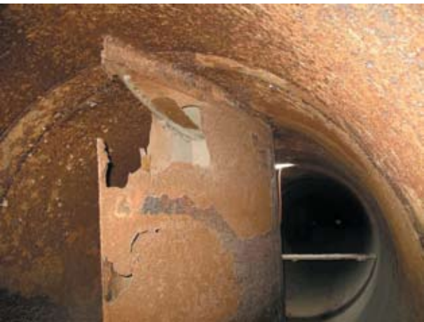
Рис. 5. Верхний горизонтальный участок напорного трубопровода Баксанской ГЭС. Глубокая коррозия экспериментальной металлической перемычки, частично разрушенной водным потоком
