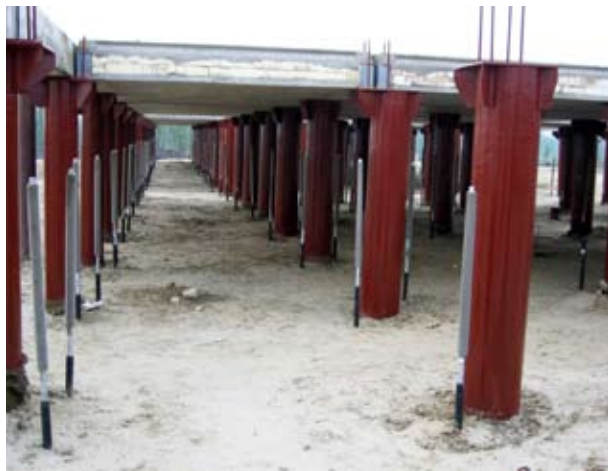
Рис. 1. Термостабилизаторы с гравитационным типом циркуляции хладагента, примененные для обеспечения твердомерзлого грунтов основания производственного здания
