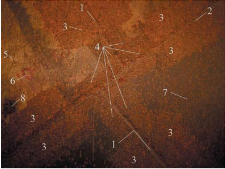
Рис. 9. Образование зон коррозии в зонах сварных швов оболочки водовода СШГЭС:
