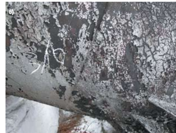
Рис. 2. Иллюстрация плохой совместимости ЛКМ, использованных для коррозионной защиты трубопроводов Баксанской ГЭС:
