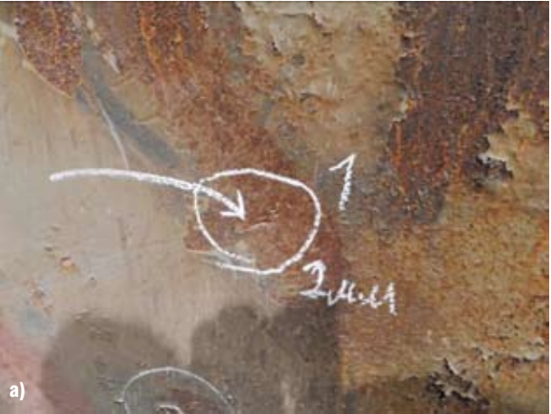
Рис. 11. Дефекты защитного покрытия спиральных камер гидроагрегатов Богучанской ГЭС
