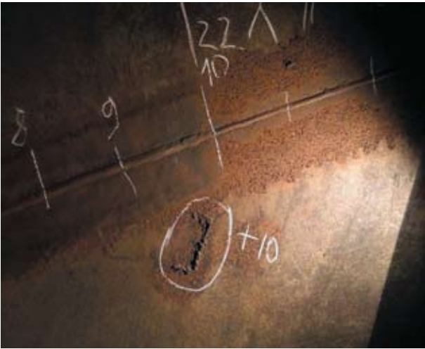
Рис. 8. Сравнительное состояние поверхности оболочки водоводов СШГЭС в зонах сварных швов с нарушенным защитным покрытием и в зонах сохранившегося защитного покрытия
