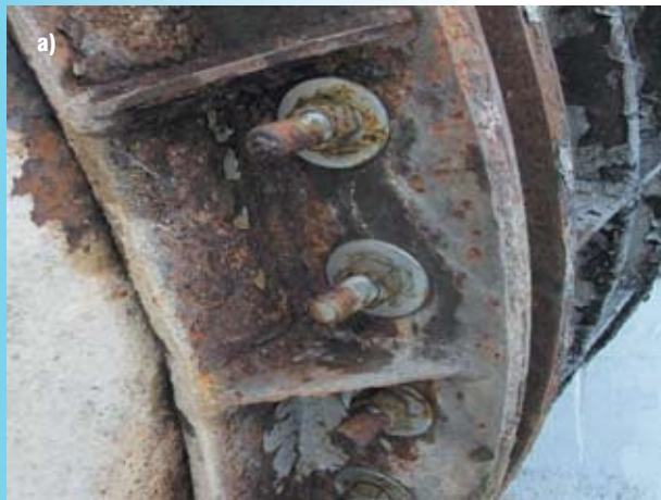
Рис. 1. Коррозия напорного трубопровода Баксанской ГЭС:
