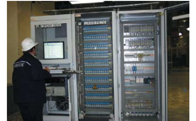
Фото 6. ПТУ-2: шкафы АРМ, реле, контроллеры SLC500
