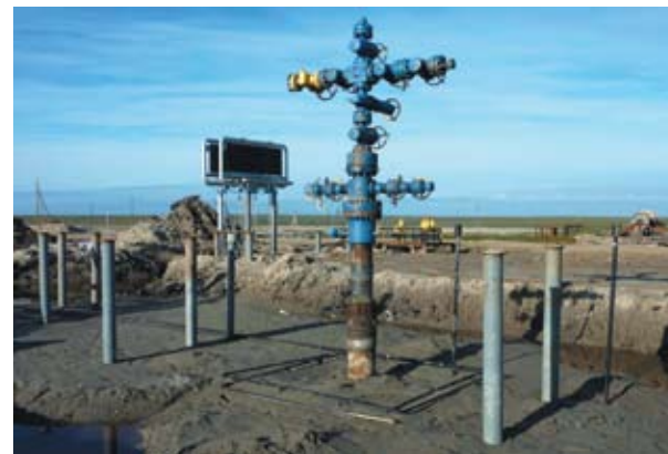
Рис. 4. Полуостров Ямал. Бованенковское месторождение. Строительство охлаждающей сезонно-действующей системы ВЕТ СТС в приустьевой зоне добывающей скважины
