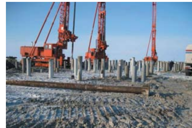
Рис. 5. Сваи с анкерной пяткой. Применены при строительстве основных производственных корпусов УКПГ-2 Бованенковского месторождения
