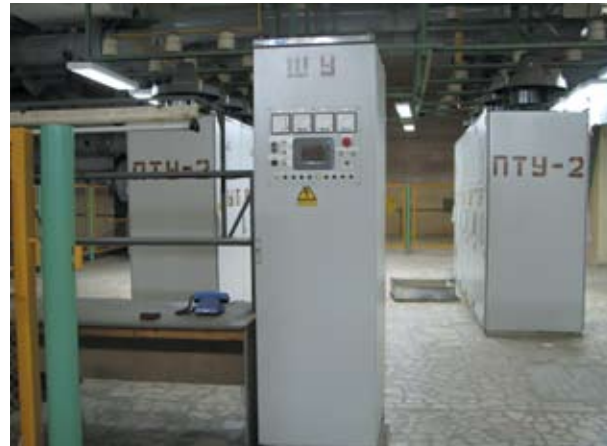
Фото 3. ПТУ-2 с преобразователем СПЧРС 15750/800МП
