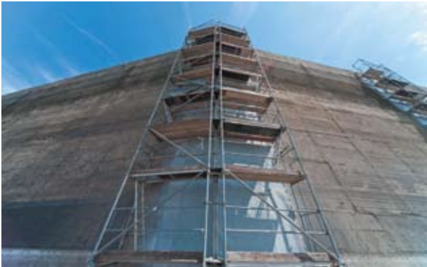
Рис. 6. Ремонт гравитационной плотины из бетонных блоков
