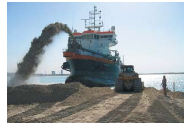
Рис. 3. «Радужная» выгрузка песка при намыве территории в Персидском заливе в Дубае
