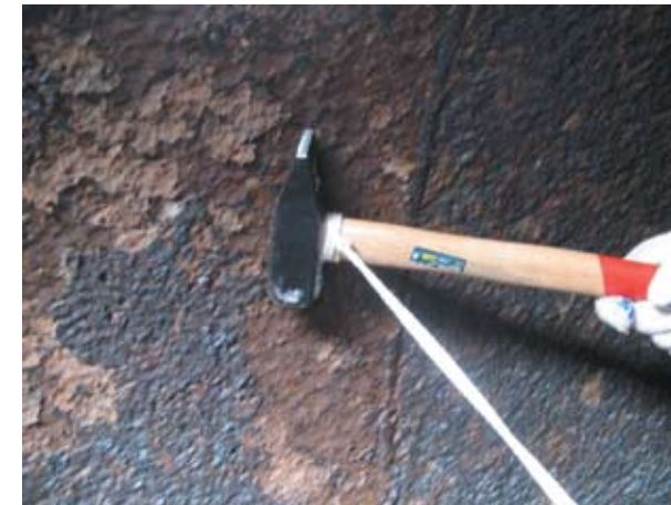
Рис. 3. Коррозионные поражения внутренней поверхности трубопровода Баксанской ГЭС.
