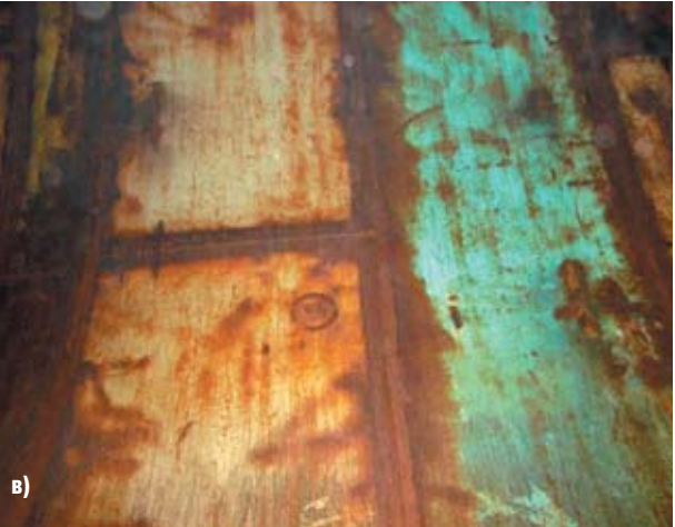
Рис. 10. Вид защитного покрытия оболочек турбинных водоводов Богучанской ГЭС. Видны участки покрытия разного цвета, выполненные в разное время. Через защитное покрытие повсеместно проступает коррозия
