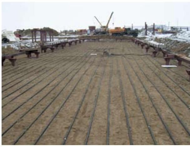
Рис. 2. Горизонтальная естественнодействующая трубчатая система тепловой стабилизации грунтов ГЕТ СТС в основании строящегося производственного здания
