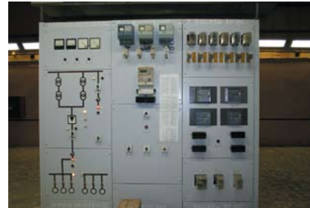
Фото 5. ПТУ-2: панели мнемосхемы, учета электроэнергии, защиты трансформаторов и управления выключателей «Сириус»
